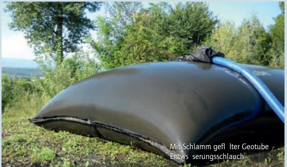
Mit Schlamm gefüllter Geotube® - Entwässerungsschlauch
