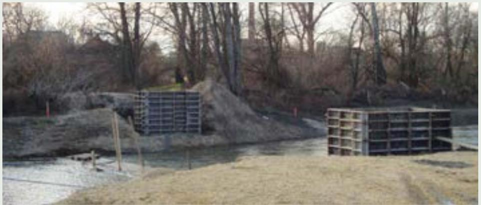
Die Fundamente für den 22 Meter langen Fischersteg zum renaturierten March-Altarm in Angern wurden bereits gegossen
