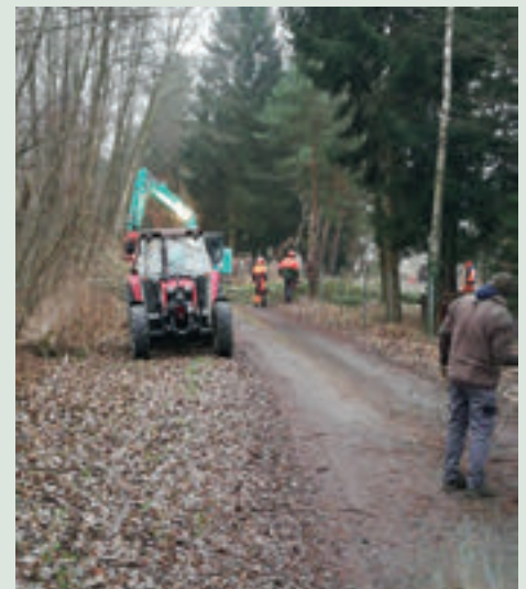
Im Vorfeld der Neuerrichtung des Hauptsteges am Ghartwaldsee waren diverse Holzschlägerungsarbeiten notwendig.
