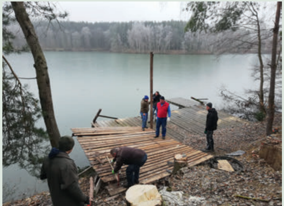
FV Ghartwaldsee: Die fleißigen Helfer beim Abbruch des alten Steges.
