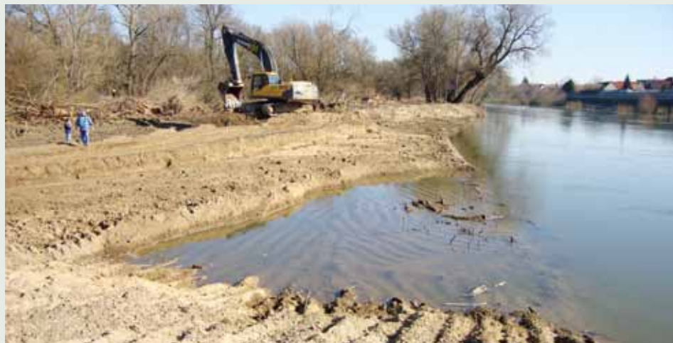
Angern: Die Grabarbeiten zur Renaturierung des Altarmes haben begonnen
