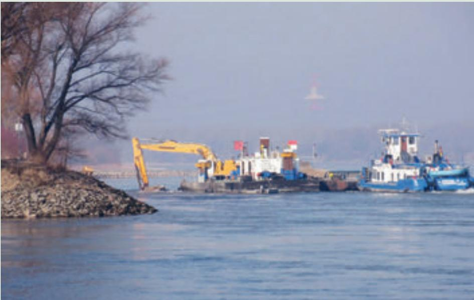
Materialrückführung zur Sohlstabilisierung an der Donau bei Haslau
