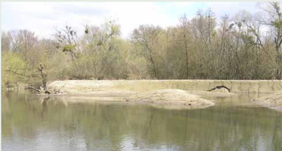
Renaturierung der Leitha: Aufweitung „Rohrfluß“ mit Steilufer und „Soll-Abbruchstelle“.
