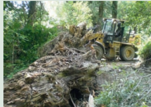
Nach dem Hochwasser in Haslau: Solch schweres Gerät wurde benötigt, um die Zufahrtswege frei zu machen
