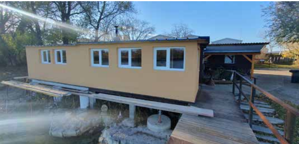
Die neue Fassade der Vereinshütte des FV Oeynhausen.
