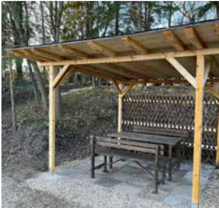
Die neu errichtete Laube als Witterungsschutz am Breiteneicher Teich. Foto: Hödl
