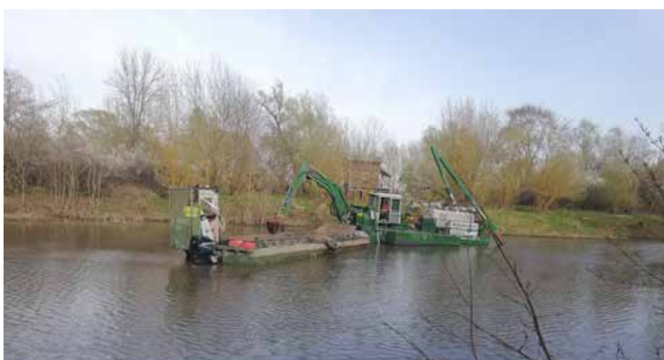
Mittels Schwimmbagger wurde der March-Ausstand vom angelegten Schlamm befreit.
