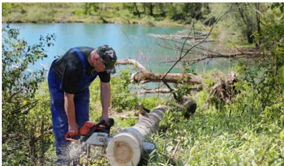
Mit schwerem Gerät wurden Biberschäden in der Wolfsgrube entfernt.
