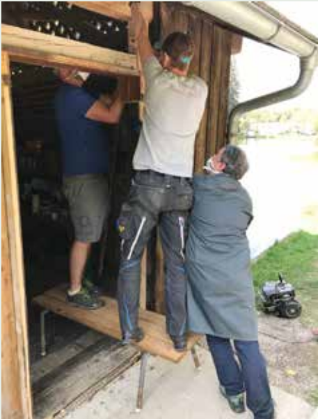
Sanierung der Hütte am Herzsee
