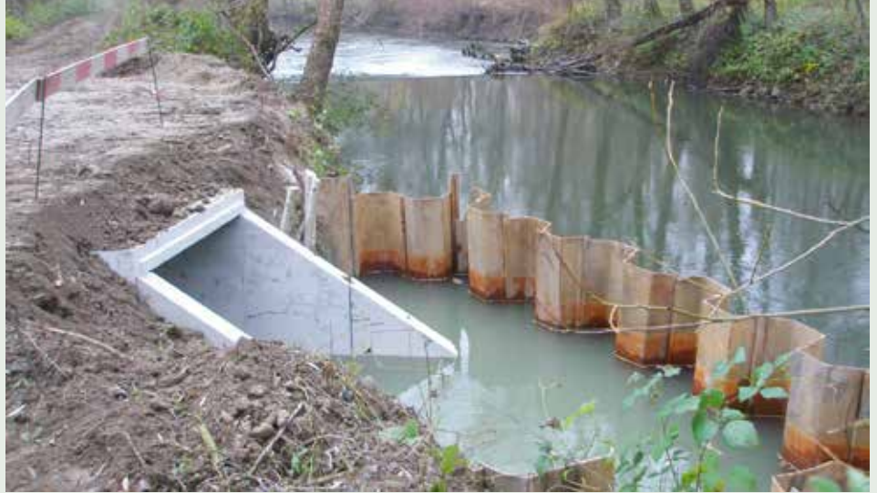
Das Ende November noch nicht fertige Einlaufbauwerk zur „Ablass-Schlinge“ – Leithaseite.
