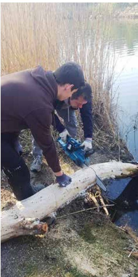
Laufende Räumungsarbeiten am Schillerwasser durch den Verein.
