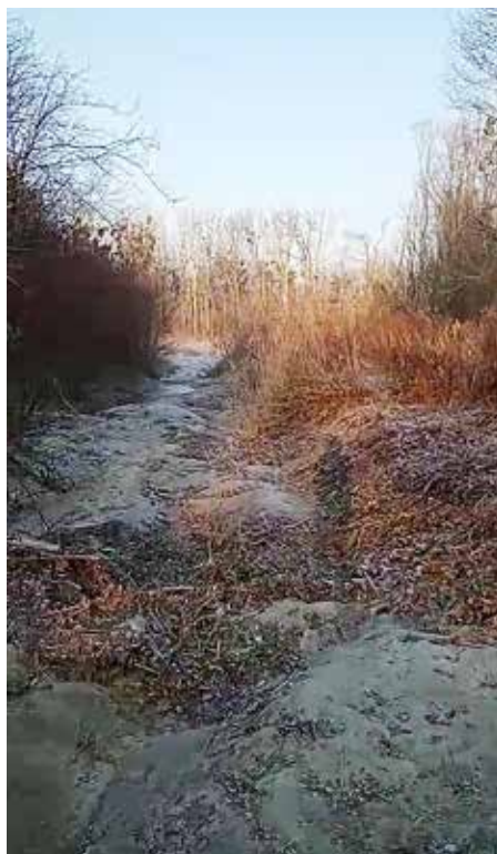
FV Leitha 7: Der durch Sedimentablagerungen nach dem Hochwasser im Dezember 2023 neuerlich stark verlandete Zulaufgraben zum Ablass.
