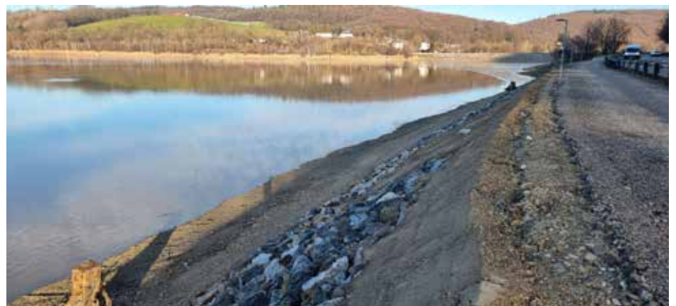
So sieht die neue Uferbefestigung des Wienerwaldsees im Bereich Wolfsgraben aus. Foto: Christian Salber
