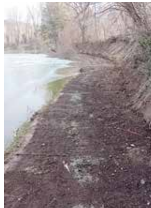
Albrechtsberger Teiche: Der Weg mit Anlandungen (li.). Der Weg nach der Sanierung (re.).
