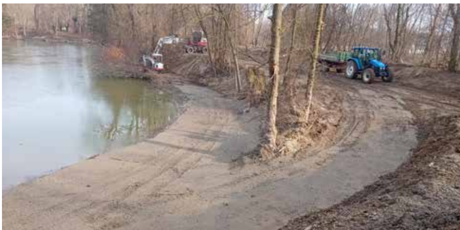
FV Loosdorf: Der nunmehr sanierte Durchbruch bei den Albrechtsberger Teichen.
