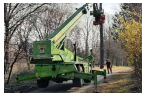
Behebung der Sturmschäden am Breitenreicher Teich durch die Fa. Heindl (Foto: Siegfried Hödl).
