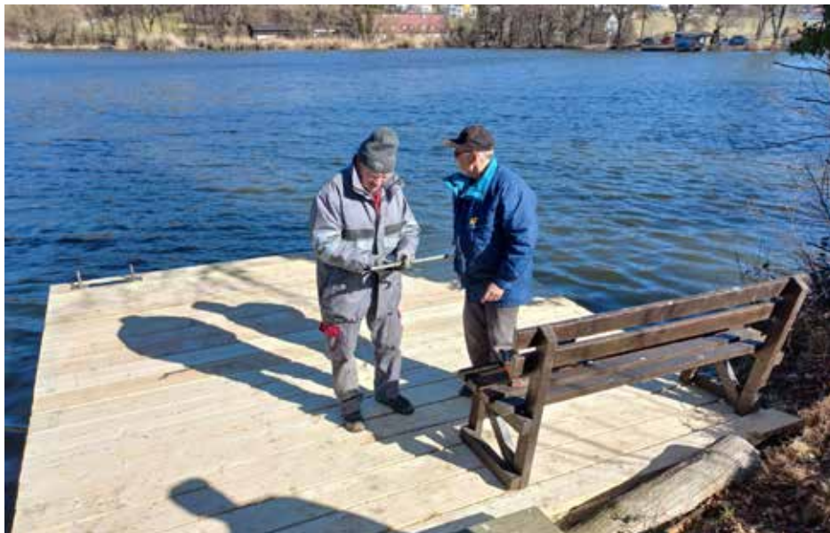
Sanierung eines Steges am Fürholz-Teich (Foto: Ernst Panauer).
