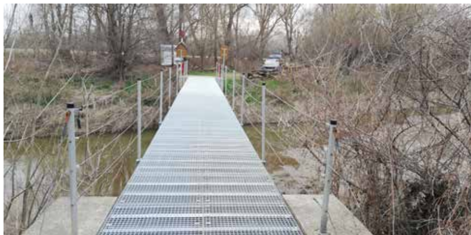
Die Sanierung des Steges über den March-Altarm in Angern ist nun abgeschlossen.
