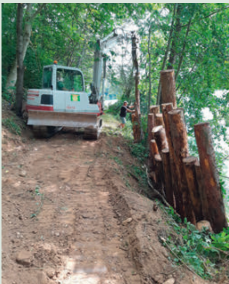
AFV-Graz: Bei der Ufersanierung des Roman-Gallin-Sees wurden Holzpfähle unregelmäßig in den Boden gepresst, um eine unregelmäßige, naturnahe Struktur zu schaffen
