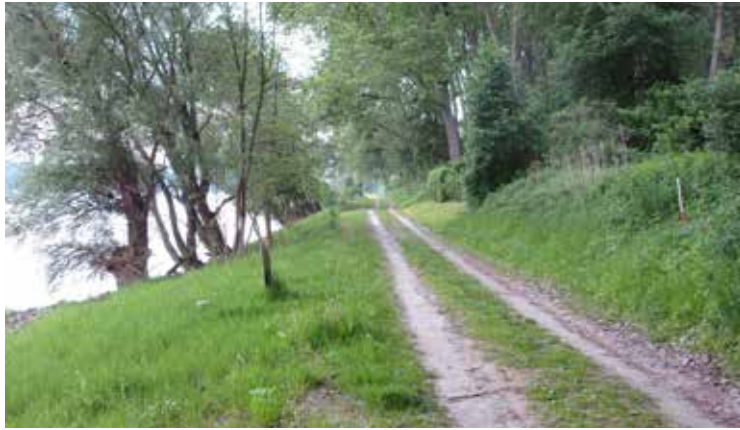
Der Treppelweg in Haslau. Dieser soll den laufenden Projekten zufolge bis zur Sohle abgetragen werden.
