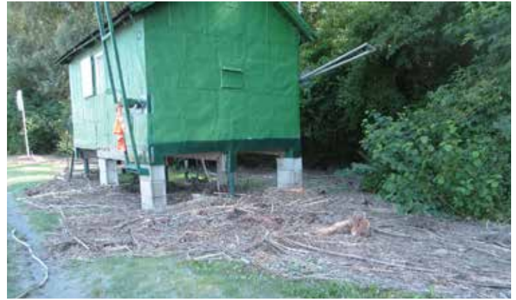
Das Hochwasser Ende Juli brachte viel Schwemmgut sowie Styropor, Glas und Plastikflaschen mit.
