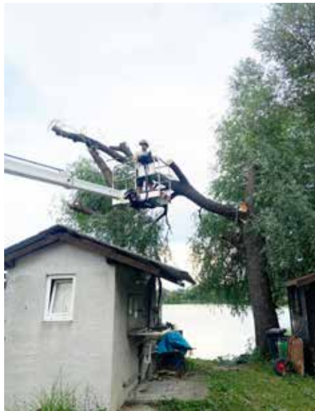
Beseitigung der Sturmschäden in Oeynhausen: Ein Baum drohte auf die Vereinshütte zu fallen.
