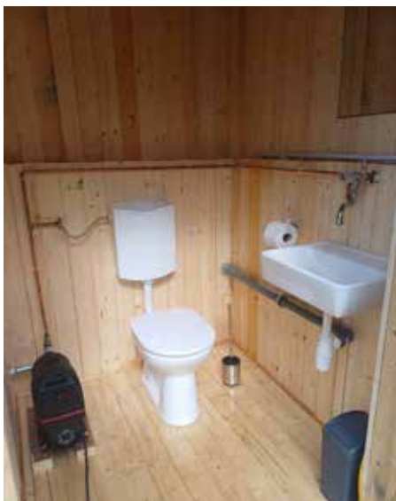
Die neue WC-Anlage am Ghartwaldsee.
