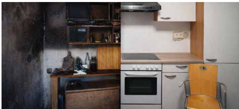
Nach dem Brand und aktuell: Renovierung der Hüttenküche am Roman-Gallin-See. Foto: AFV-Graz
