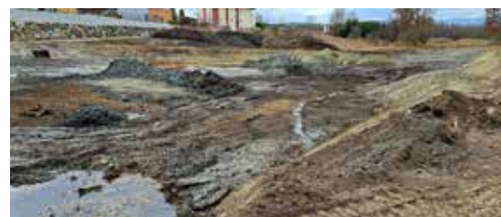
FV Knittelfeld: Die Teichanlage Blickner nimmt bei der Erweiterung bereits Formen an.
