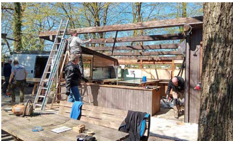
FV Wieselburg: Beginn der Hüttendachsanieuerung. Foto: Manfred Schuster.
